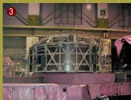
柏崎刈羽原発はひびが入った炉心隔壁を検査するために停止した
